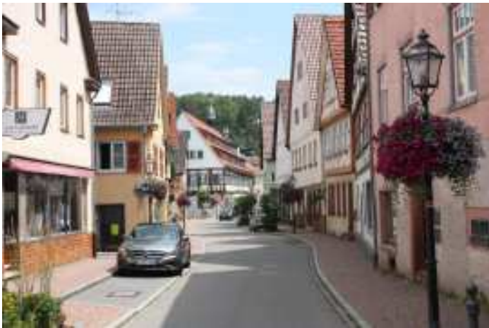
Fachwerk und verputztes Fachwerk.
